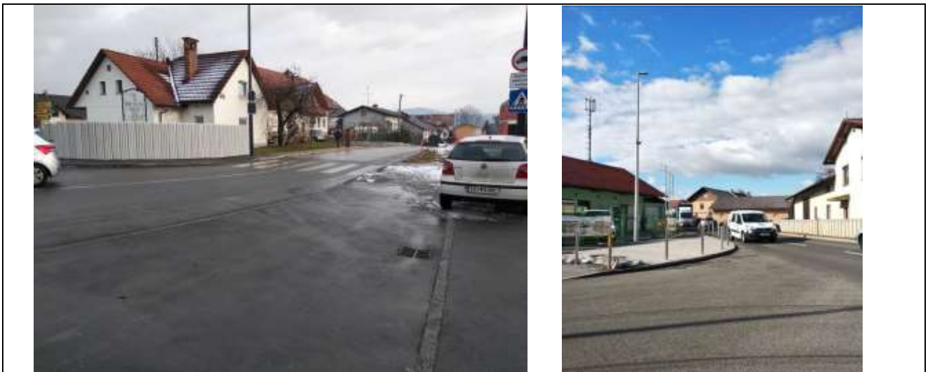
Slika 10: Neprimerna lokacija prehoda za pešce pri Kmetijski zadrugi.
