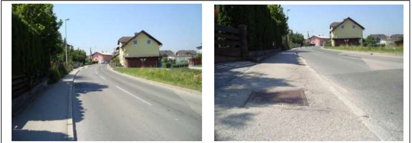
Slika 8: Pločnik na tej cesti je preozek in nevaren zaradi nagiba na cesto (predvsem pozimi).
