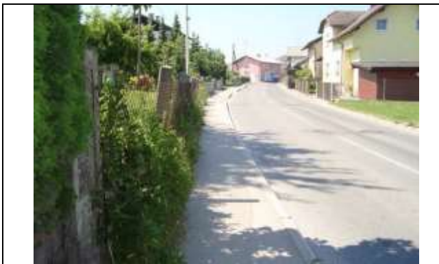
Slika 9: Nagnjenost ograje na pločnik.
