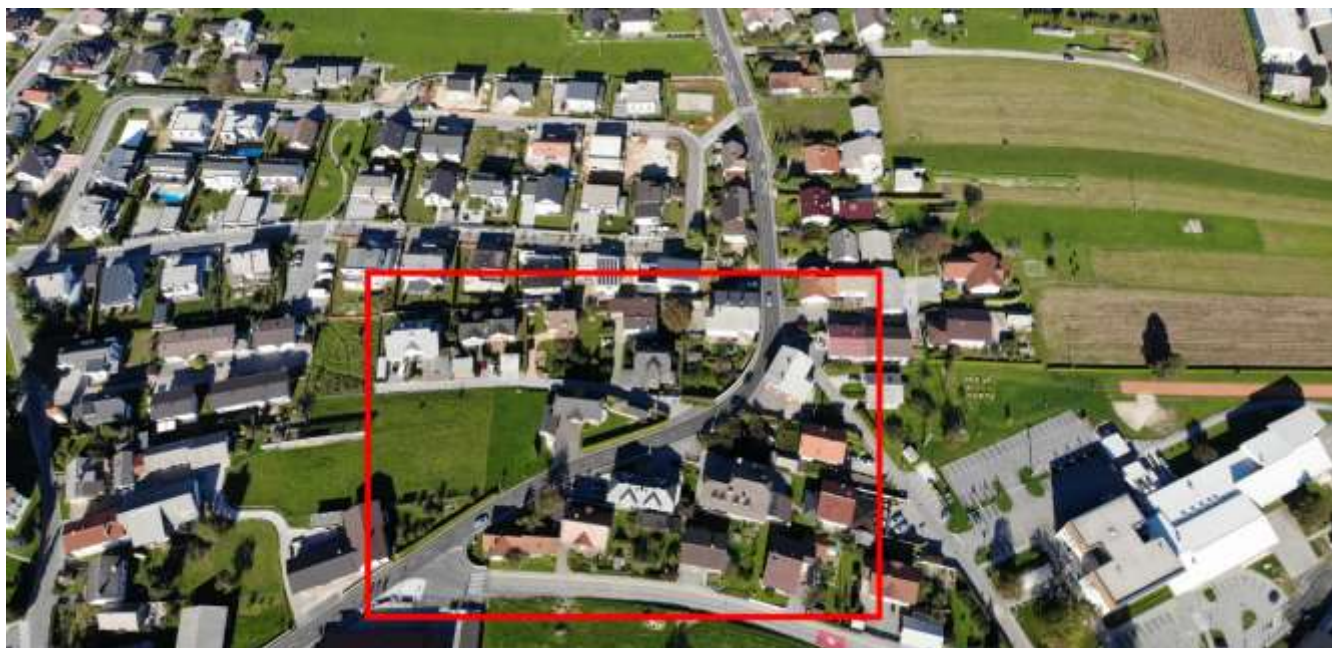
Slika 5: Odsek Kamniške ceste brez pločnika in brez prehoda za pešce – nevaren odsek.
